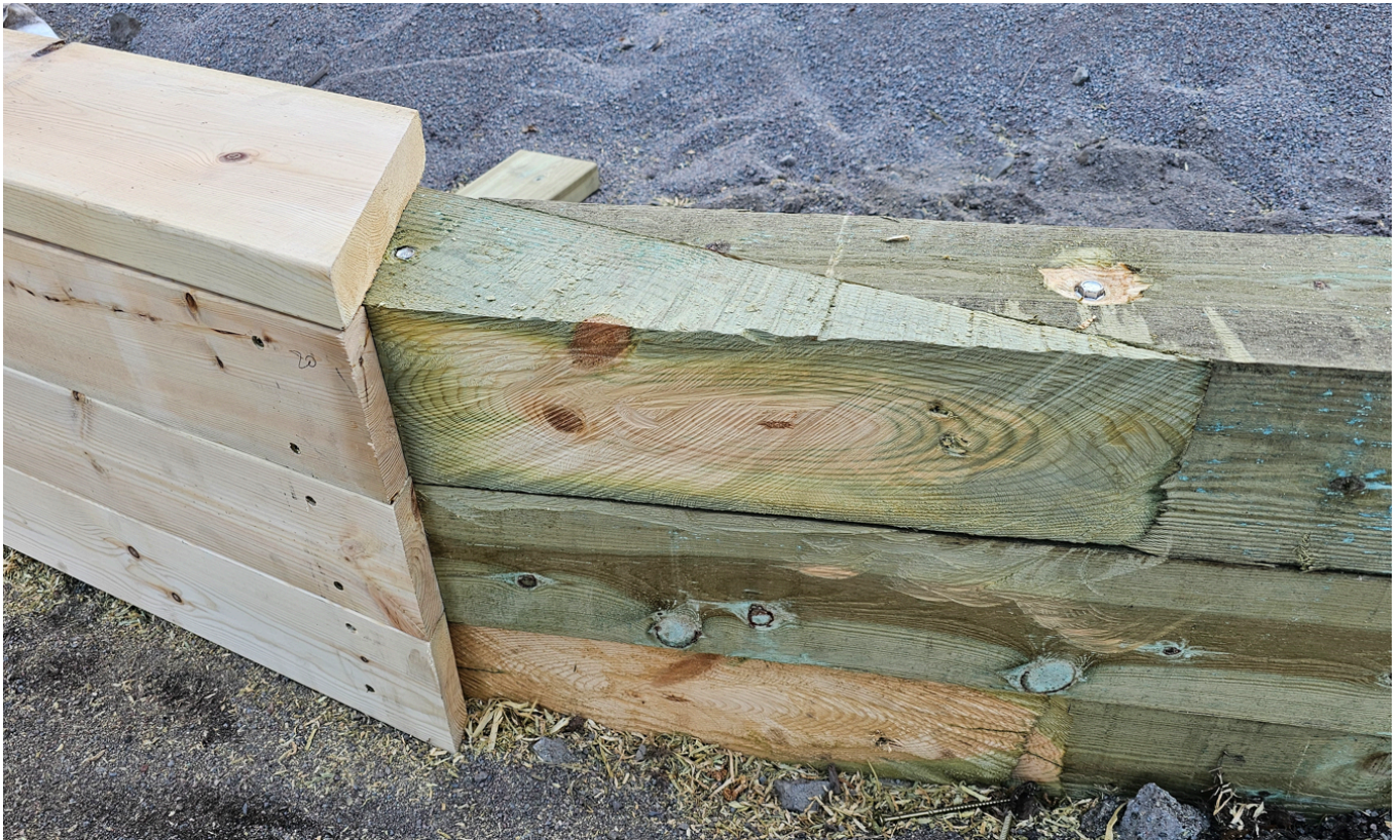
Bild 2 och 3: Stomme till baksandlåda byggs i tryckimpregnerad sparr som därefter kläs med annat virke.
