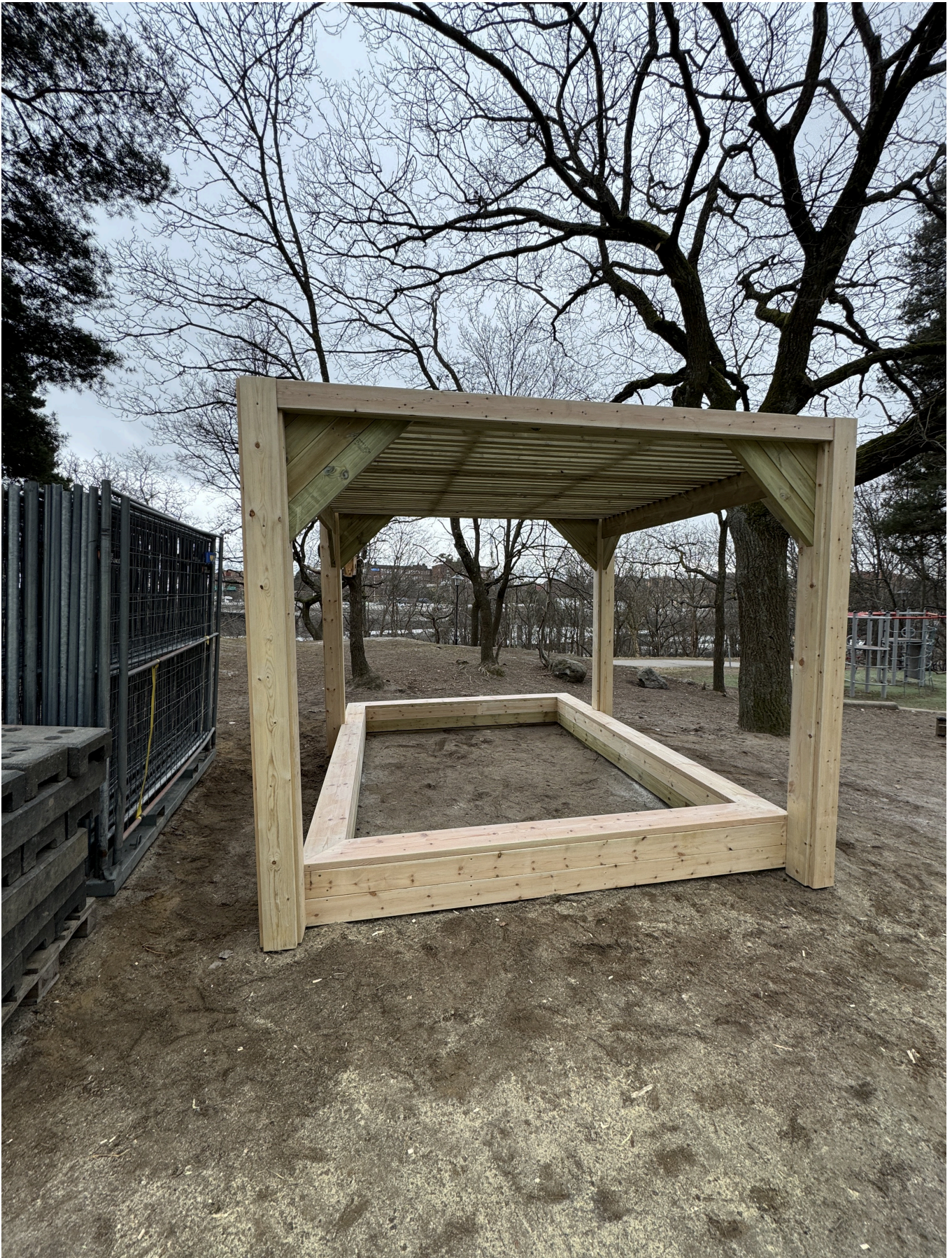
Bild 1: Hela konstruktionens stomme, stolpar samt tak är byggt i tryckimpregnerat trä. Därefter har
